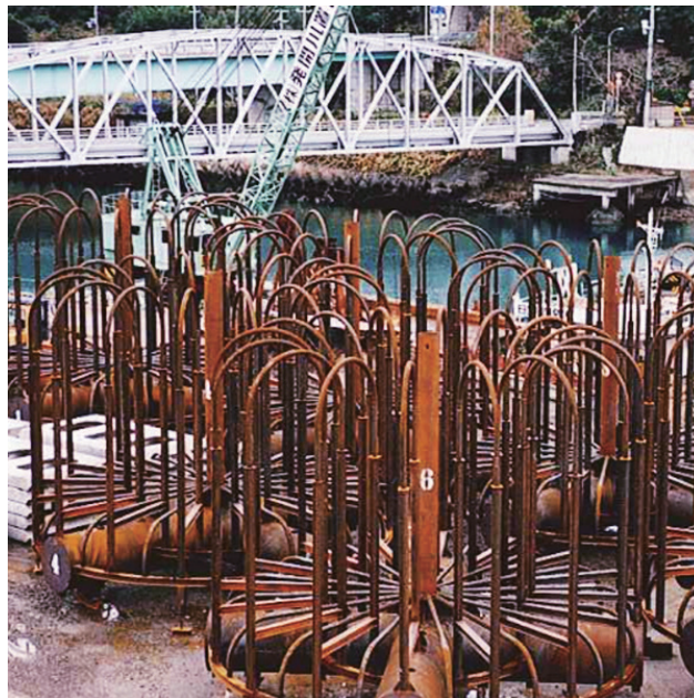
鋼製魚礁製作
