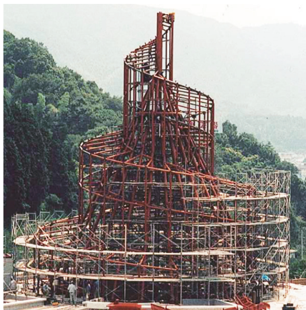
特殊鉄骨(公園)工事
