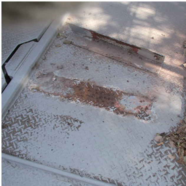
タイヤ止め補修前
