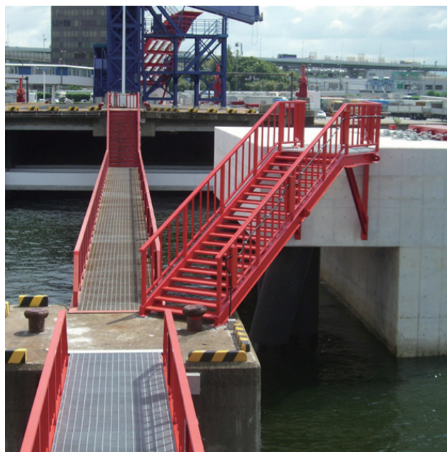
南港網取棧橋製作
