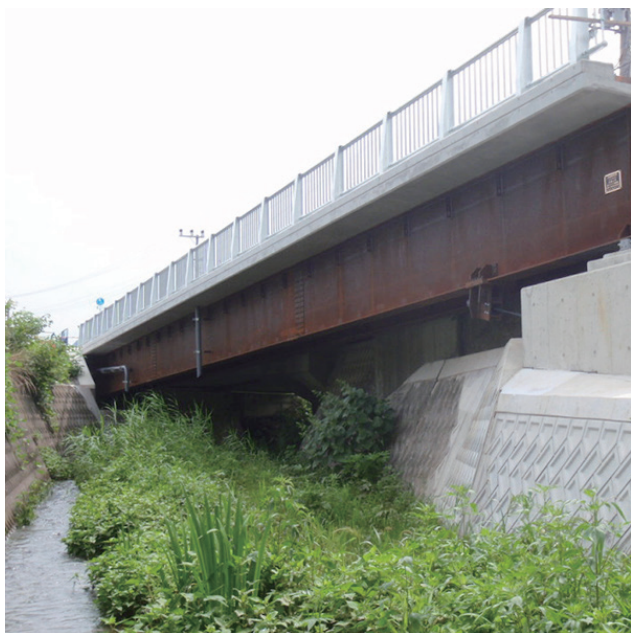
道路交付全交通安全工事
