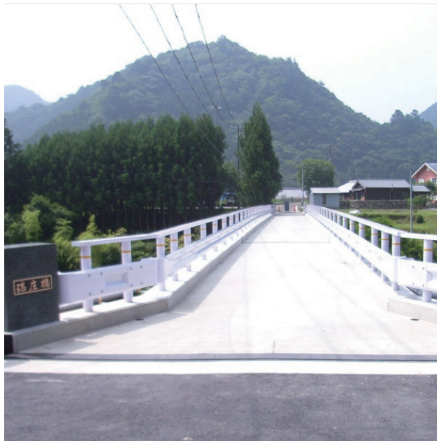
道路橋製作架替工事
