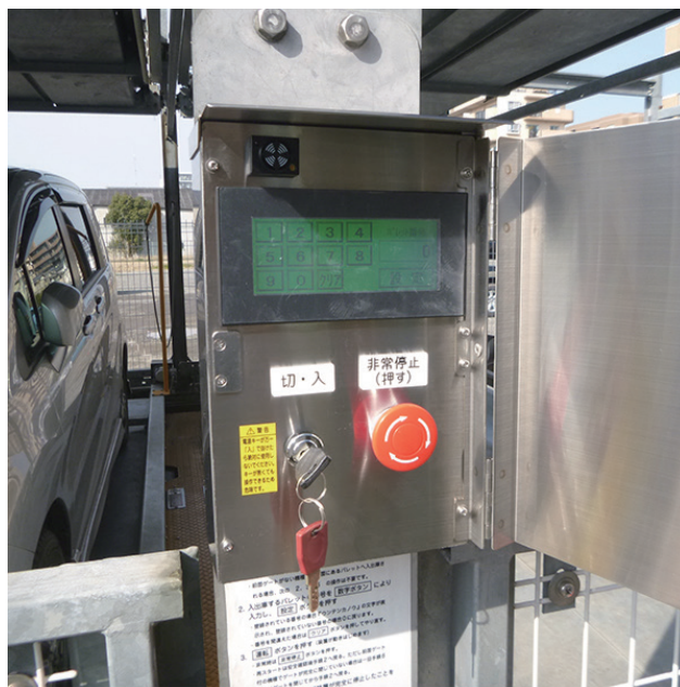
操作盤更新後
