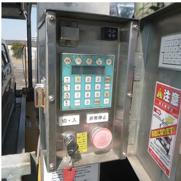
操作盤更新前
