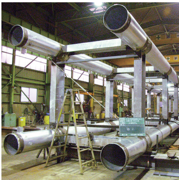
照明鉄塔製作
